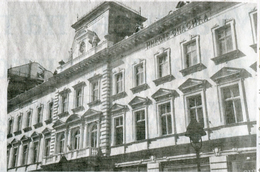
Поклоњене зграде у Кнез Михаиловој улици у Београду
